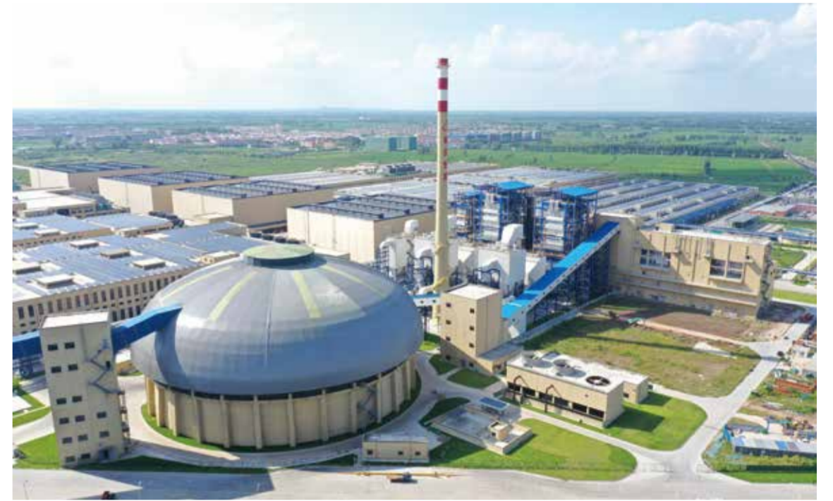
江苏桐昆恒阳化纤厂区。
