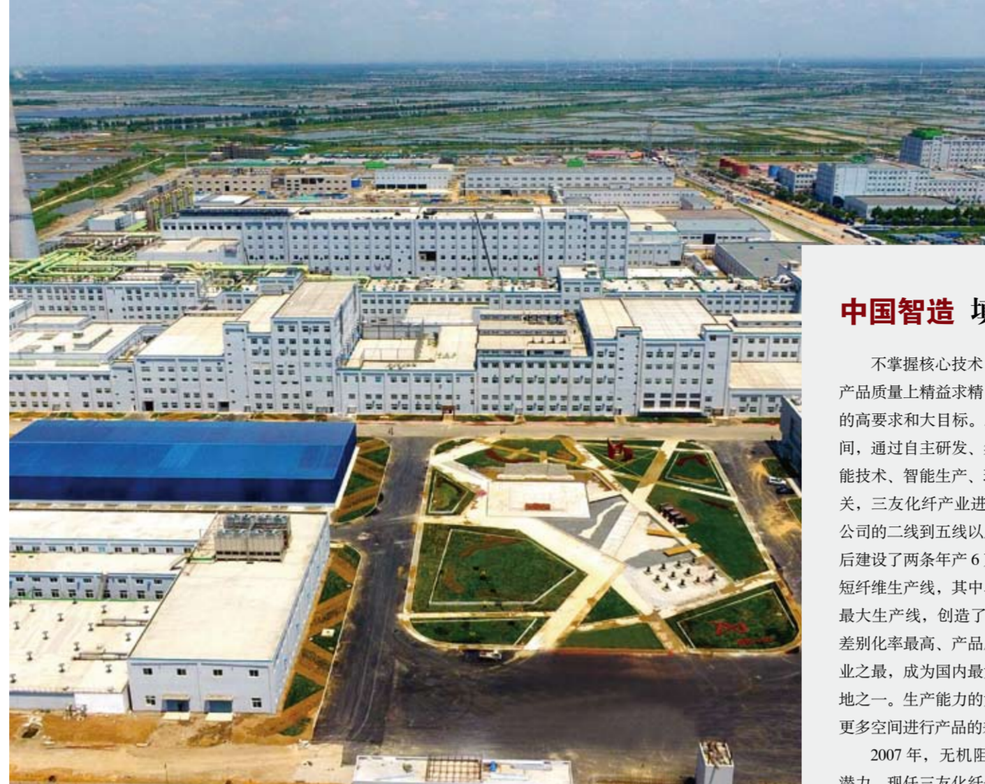
唐山三友集团兴达化纤厂区及车间。
